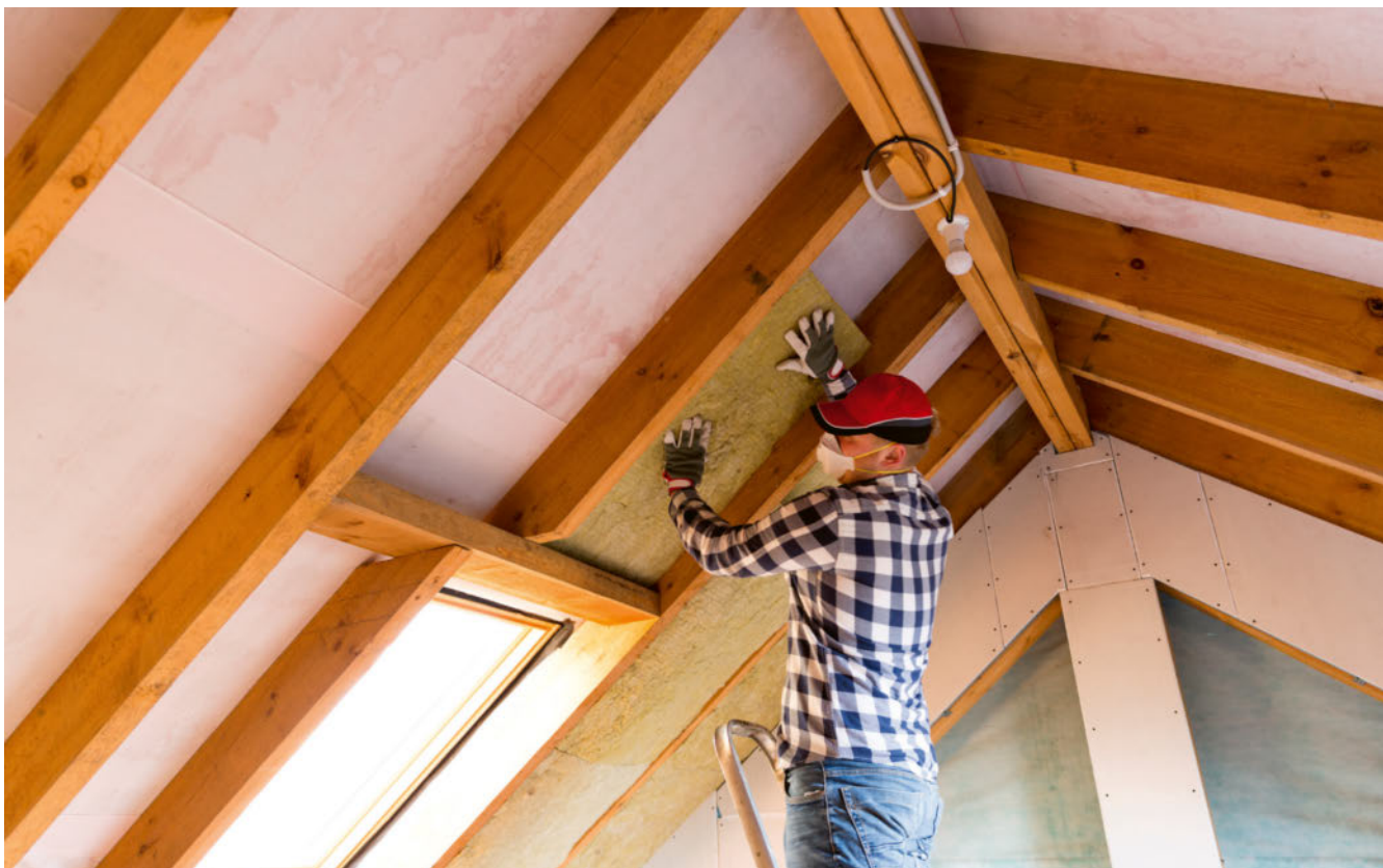
Att täta taket leder till stora vinster när det gäller energiförbrukningen. Foto: Adobe Stock
