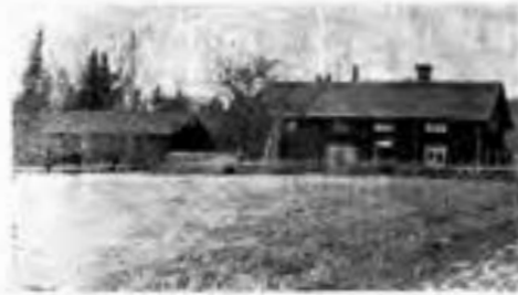
Kvittetorpet Rönns i Flästa. De närliggande byggnaderna. Flästa köpbygd med stugor.
