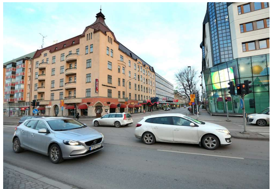
Hamngatan föreslås till viss del begränsas för biltrafik, och kommer under en betydande tid att stängas av på grund av ombyggnation, skriver fastighetsägare i Karlstad.
