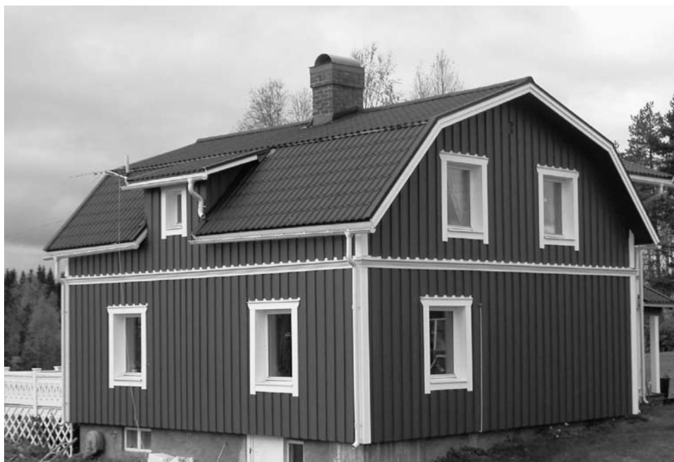
Hus med mansardtak.
