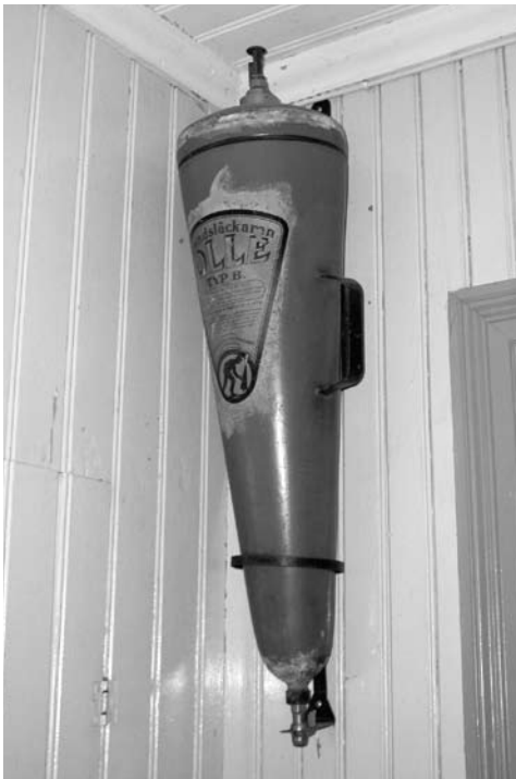
Brandsläckaren Olle som inte fick frysa.
