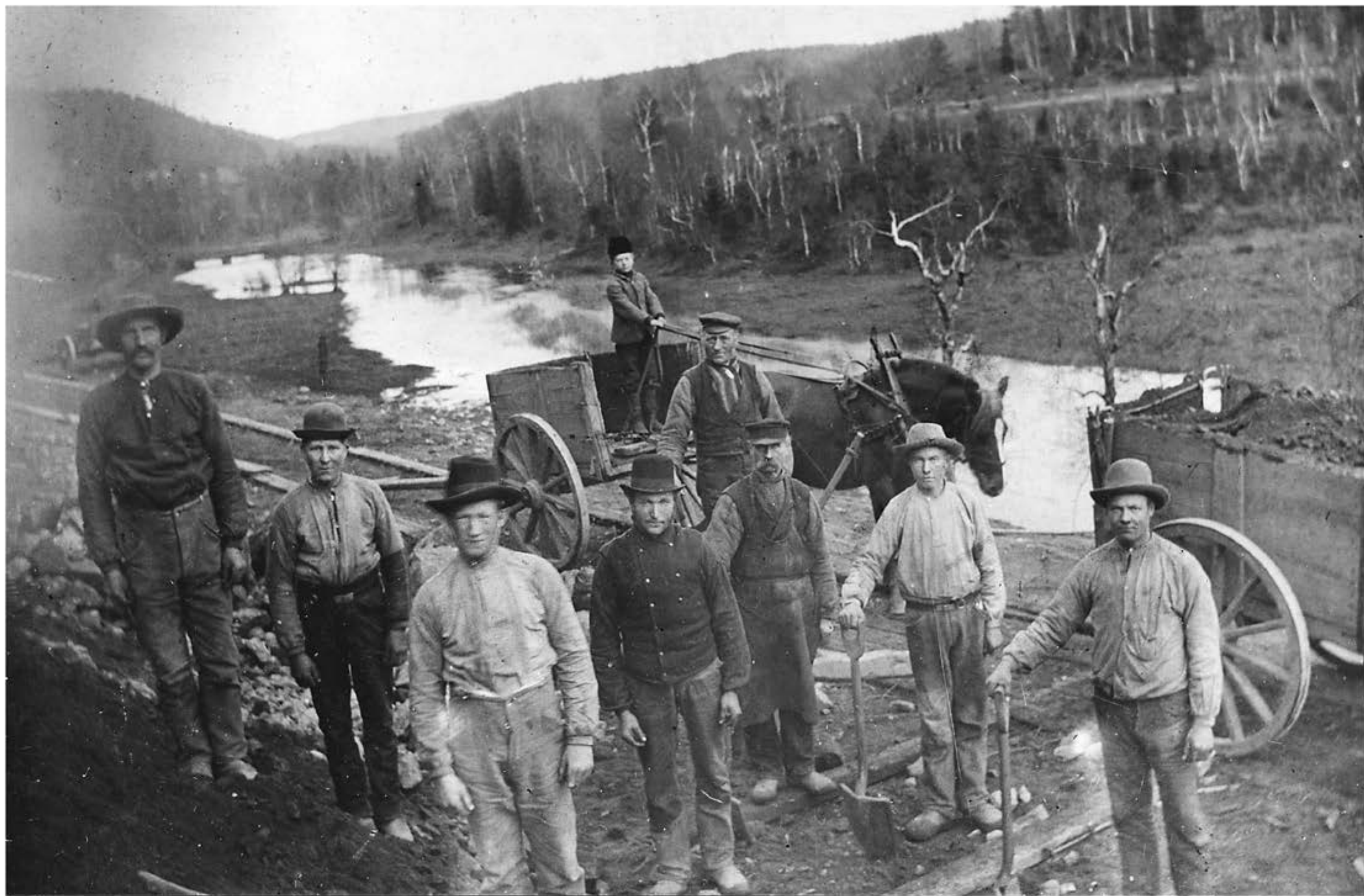
Att bygga järnväg var ett tungt arbete. Här tar rallarna en liten fotopaus vid Sörån (Buagärde ) mellan Bollebygd och Olsfors.
