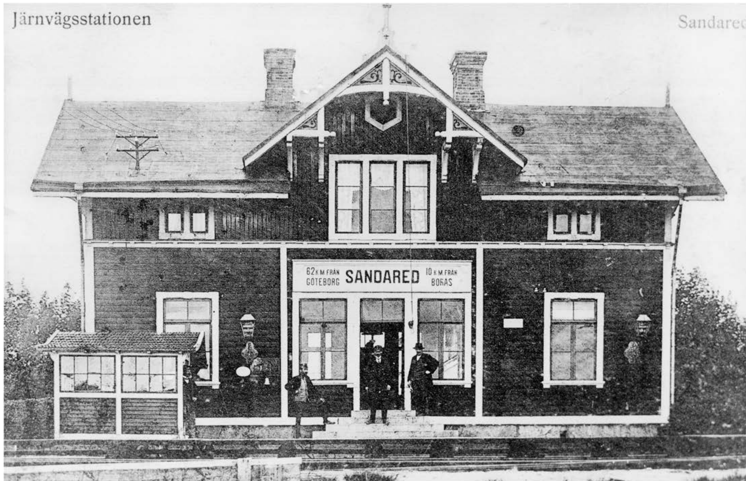
Sandareds station hörde till de byggnader som stod färdiga, när trafiken på banan började i slutet av 1894. Huset brann ner 1902 men återuppfördes samma år. Bilden är från tidigt 1900-tal.
