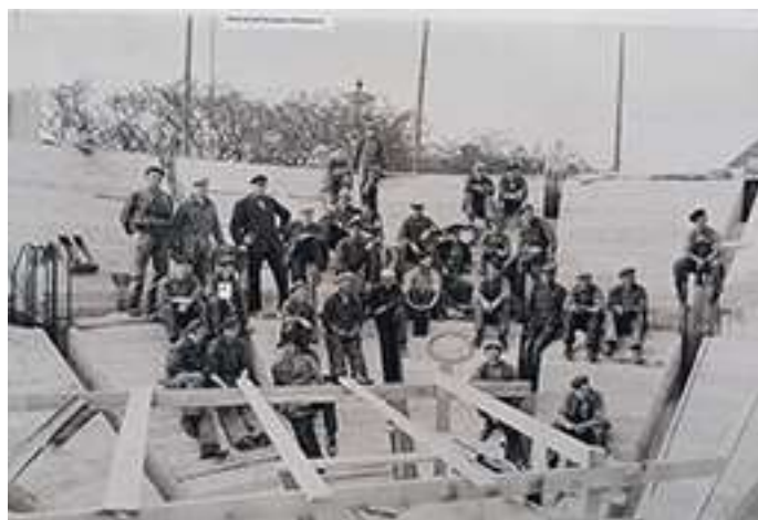
En bild från förr. Bygget av silon i hamnen, den silo som revs häromåret.
