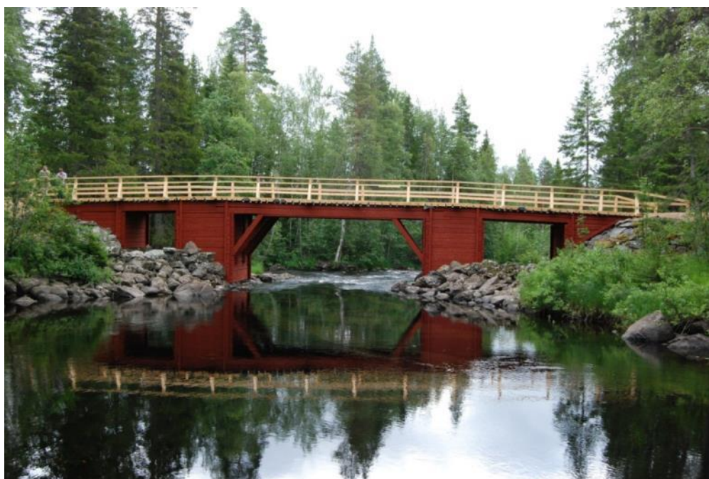
Sågforsbron efter rekonstruering. Hela brokonstruktionen utom brobana och räcke är målade med röd slamfärg. Foto: 2012
