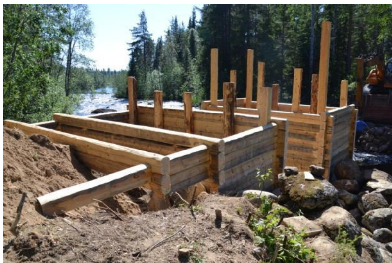
Timmerkistorna vid landfästena uppfördes med avtrappning mot älvstranden. Stående "följare" på kistornas insidor monterades med återanvända förankringsjärn från den ursprungliga bron. Foto: 2011
