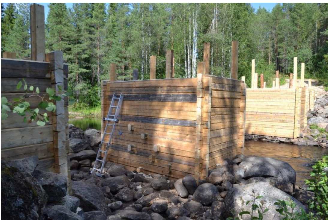
De fyra rekonstruerade timmerkistorna. Här syns de intimerade "betingarna" i underdelen av kistorna. Foto: 2011
