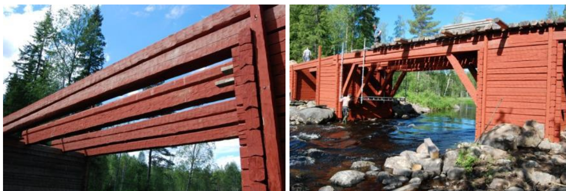
Tv: Spåren efter timmermännens hantverk präglar bronns uttryck. Här syns de kraftigare brobalkarna i bronns mittspänn. Th: På balkarna i bärverket monterades syllar som utgör själva brobanan och som även ger stöd åt broräcket. Foto: 2012
