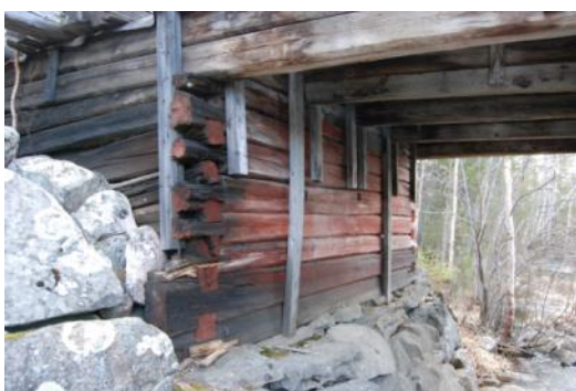
Tv: Större delen av brokonstruktionen var kraftigt angripen av röta Foto: 2011
