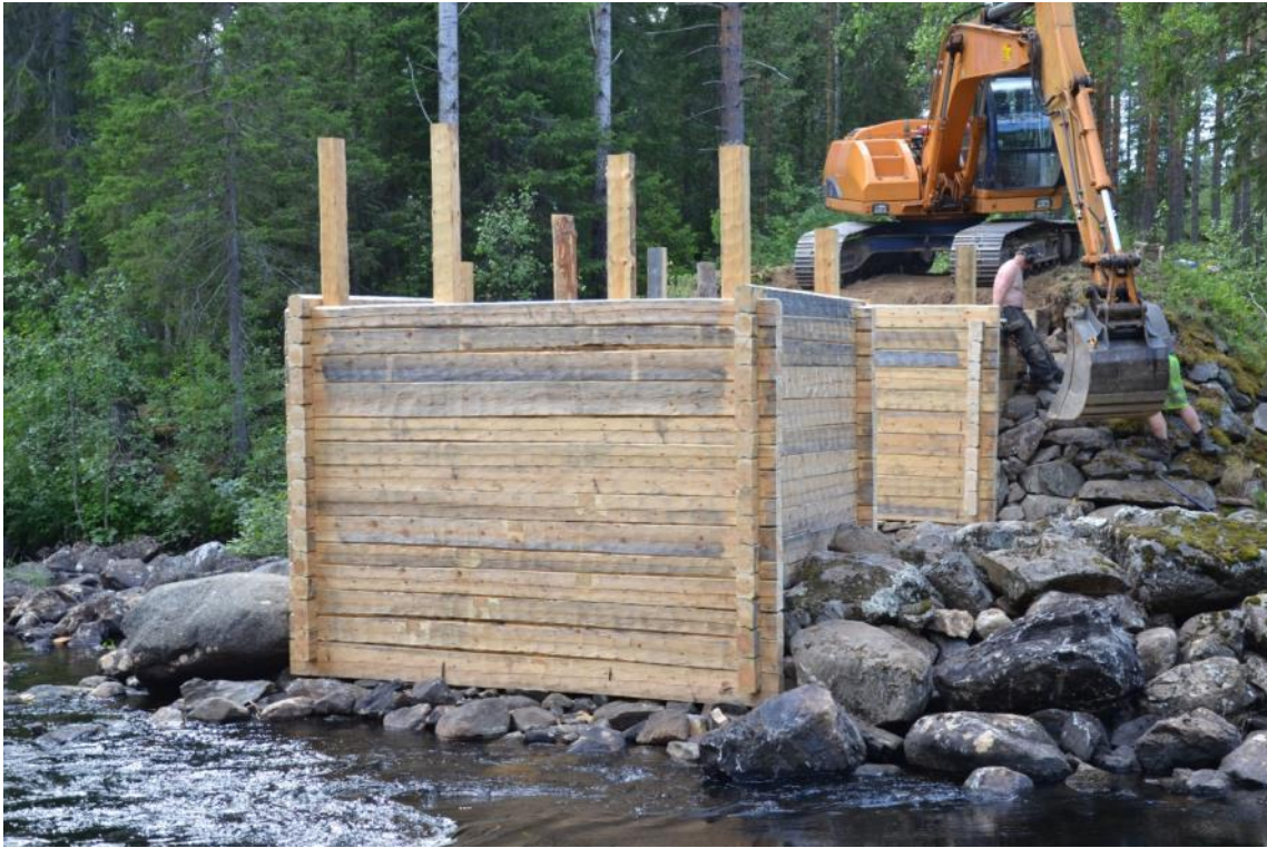
Efter upptimringen av de nya kistorna återställs stenkönorna mot kistornas sidor, vid landfästen och mellanstöd. Foto: 2011
