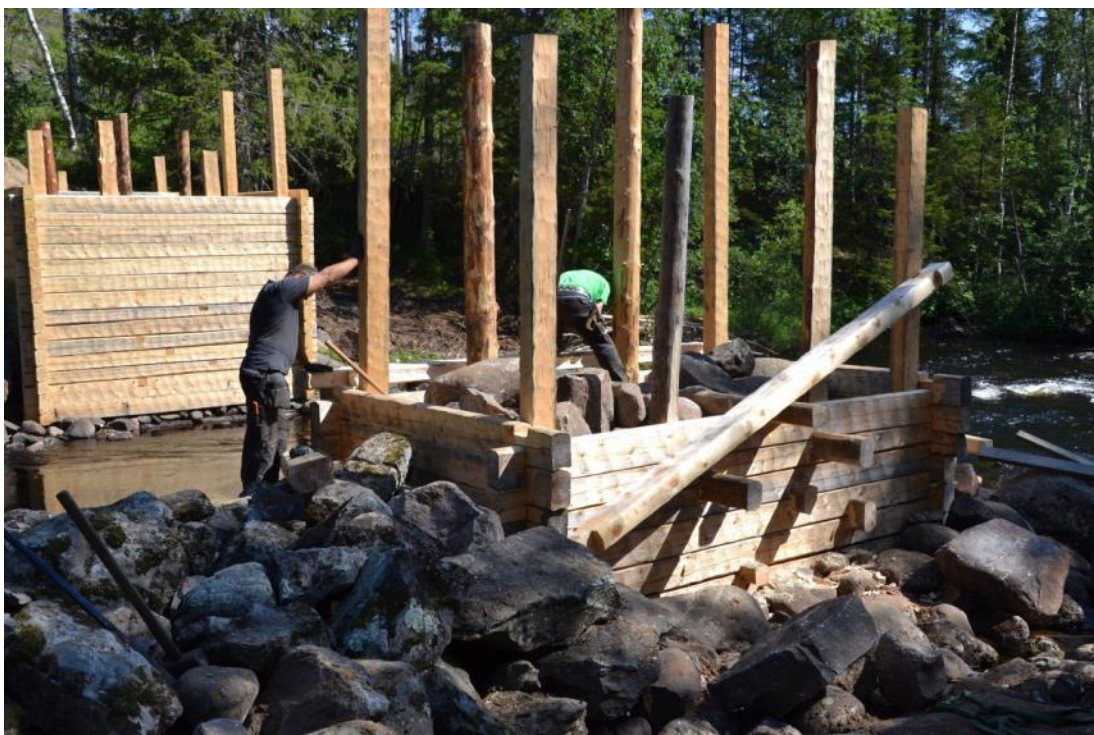
Återfyllnaden av sten skedde löpande i takt med att timringsarbetet framskred. Foto: 2011
