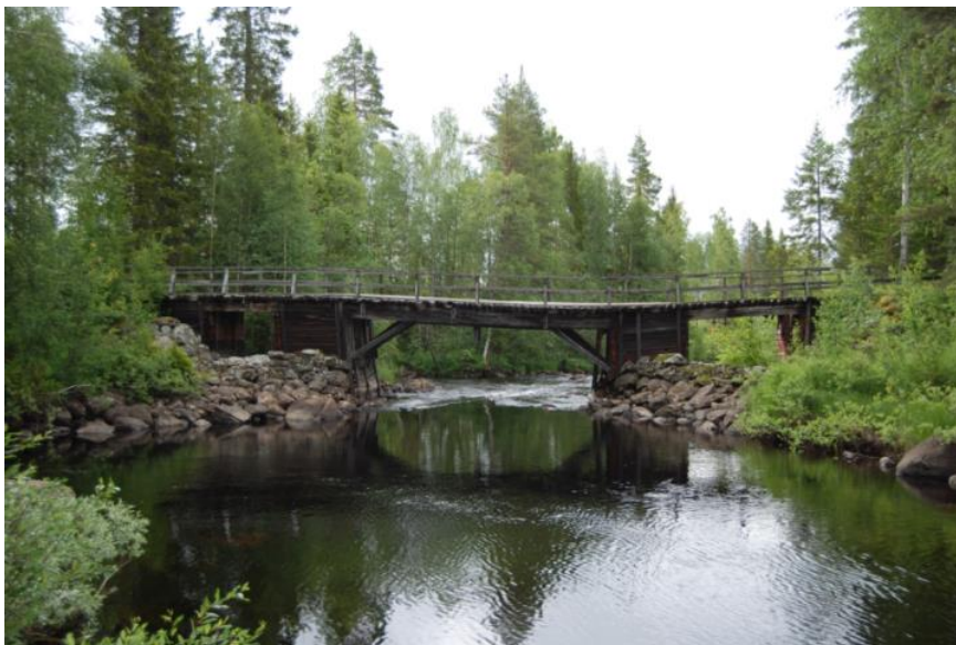
Sågforsbron före rekonstruering. Konstruktionen har "satt sig" och sviktar under tyngden av senare tidens insatta stålbalkar samt skador på brons timmerkistor. Foto: 2009
