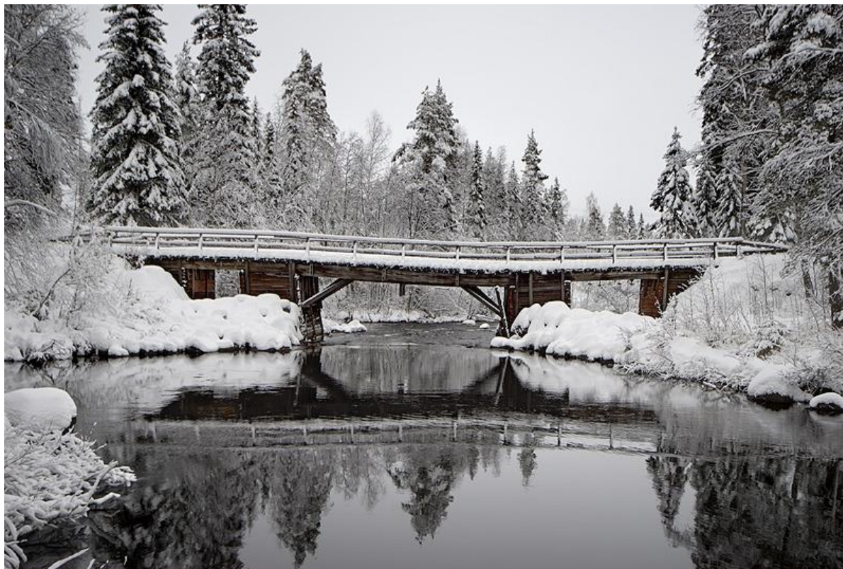
Sågforsbron över Lillpiteälven i Åträsk uppfördes kring år 1902 och är Norrbottens enda bevarade större träbro. Foto: Daryoush Tahmasebi, Norrbottens museum 2007
