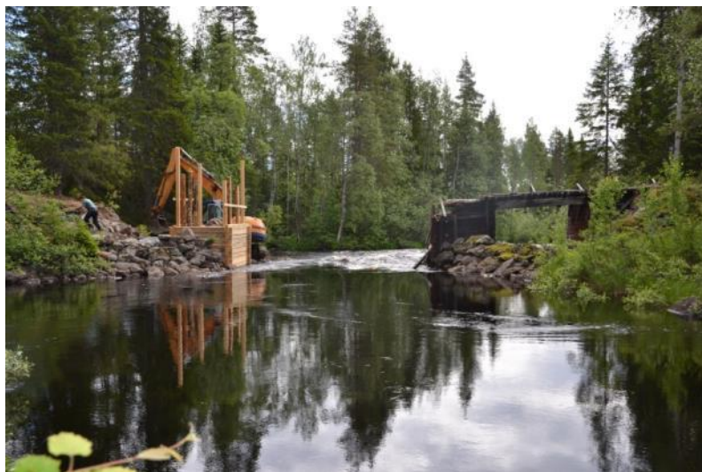
Efter nedmontering av befintliga timmerkistor samt brobana i sidospänn och mittspänn, påbörjades resningen av de rekonstruerade timmerkistorna. Foto: 2011
