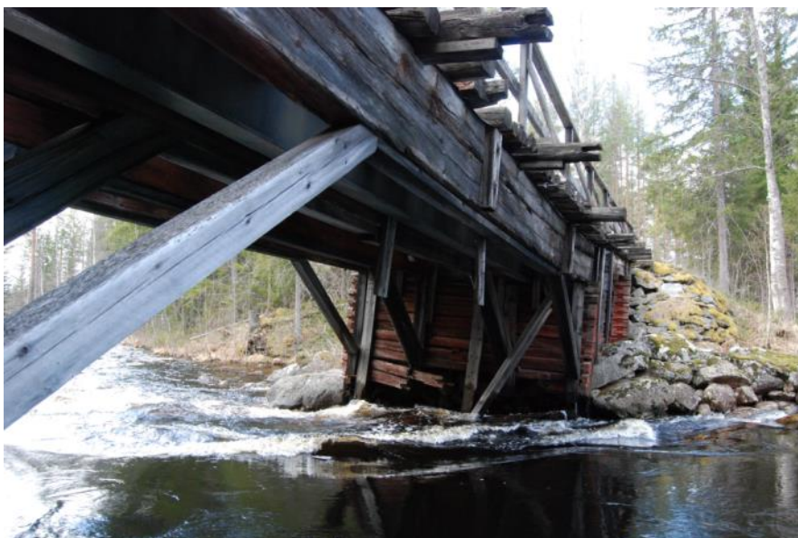
Bron var förändrad vid flera tillfällen. Längst upp till vänster i bild syns sentida förstärkningar i form av stålbeamer som moterades i mitten av 1980-talet. Foto: 2011
