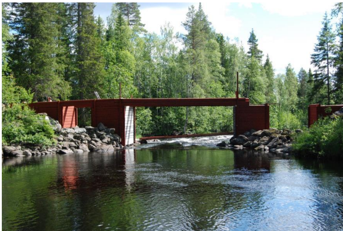
Brobalkarnas montering på timmerkistorna. Foto: 2012
