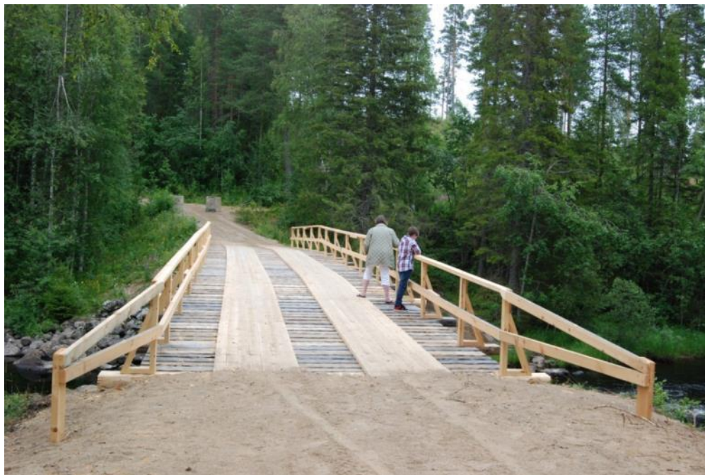
På brobanan som består av tvärlagda syllar monterades räcke och slitplank i två längsgående banor. Foto: 2012
